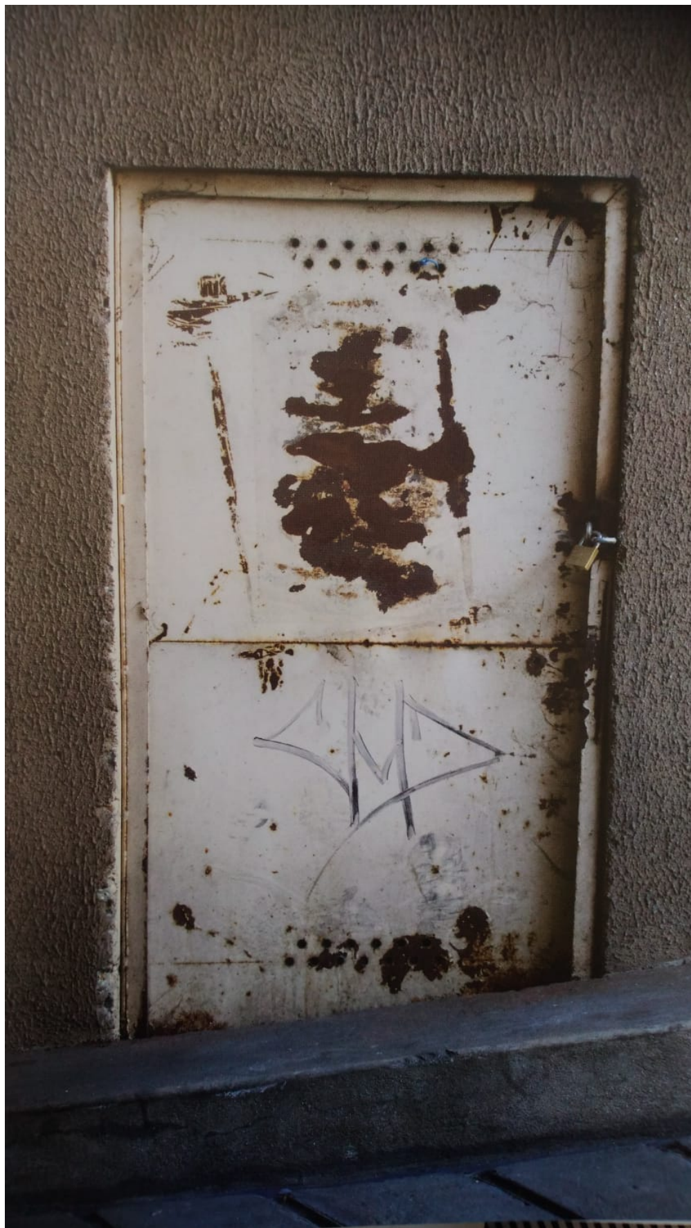
LE MUR SUR LEQUEL TRAVAILLER
